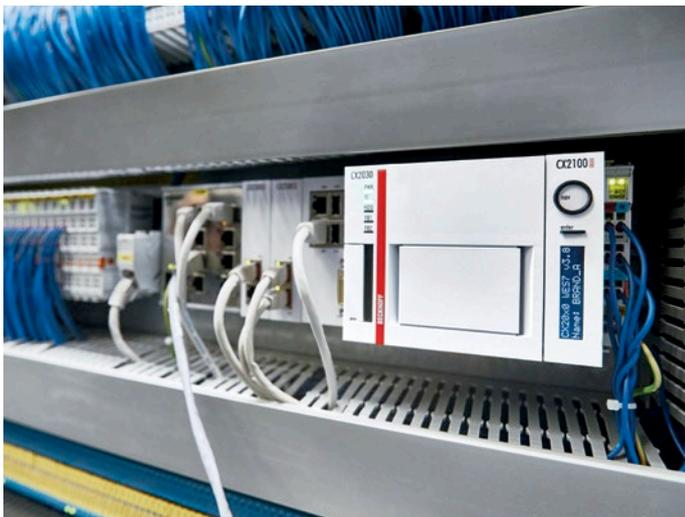
Die Entrauchungsanlage wird über den Embedded-PC CX2030 gesteuert.
