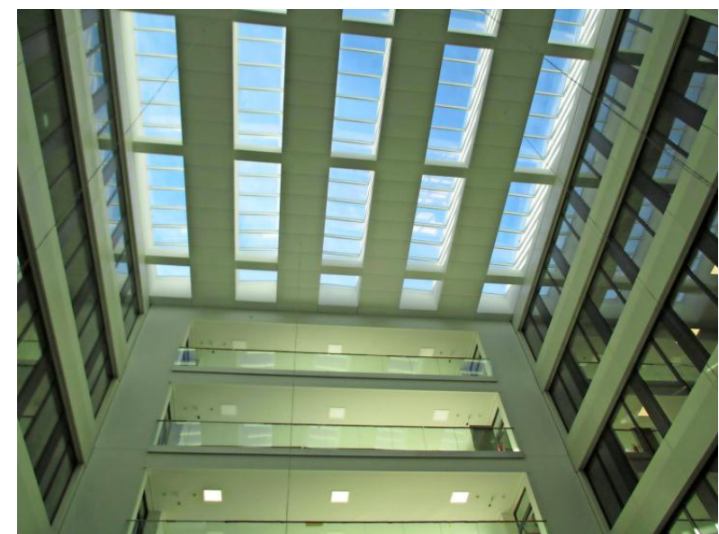
Viel Licht fällt von oben in das Atrium in einem der Mitteltrakte. Dort soll im Aufenthaltsbereich die Kommunikation der Mitarbeiter im Mittelpunkt stehen.
